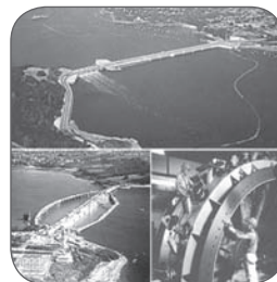
Slika 5. Elektrana koja koristi snagu plime i oseke, 240 MW La Rance, Francuska.
