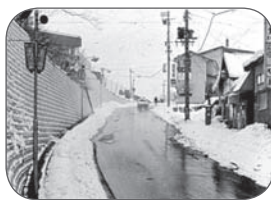
Slika 4. Zagrevanje ulica geotermalnom energijom, Japan.
